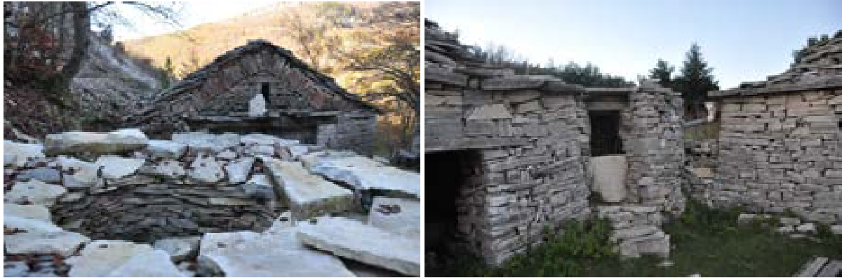
photos 7 et 9 : rénovation de citernes collectant les eaux toiture, à proximité d'anciennes bergeries, aujourd'hui simples lieux de récréation.
