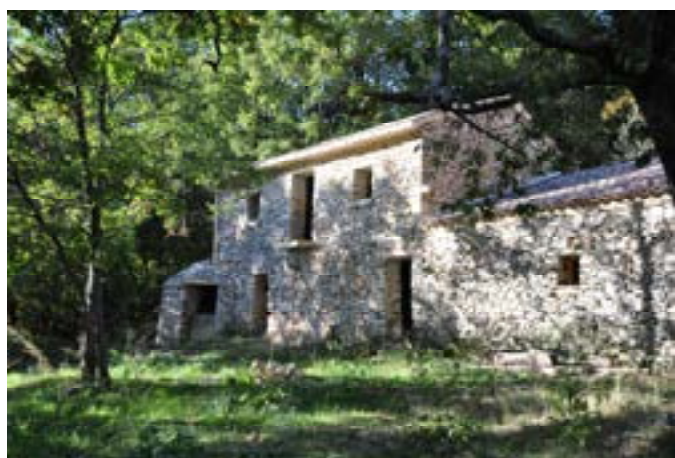
photos 6 et 7 bis : rénovation d'une bergerie en montagne de Lure, deux citernes raccordées aux eaux pluviales, la traditionnelle (à gauche de la façade) et une nouvelle de 20 m 3 . Réflexion en cours pour un usage domestique.
