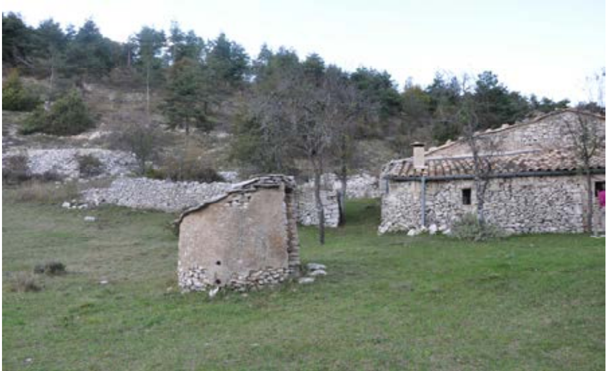
photo 1 : à proximité immédiate ou non, la citerne, creusée dans le sol et maçonnée, est remplie avec l'eau de ruissellement des toitures. Une poulie ou une pompe donnent accès à l'eau stockée
