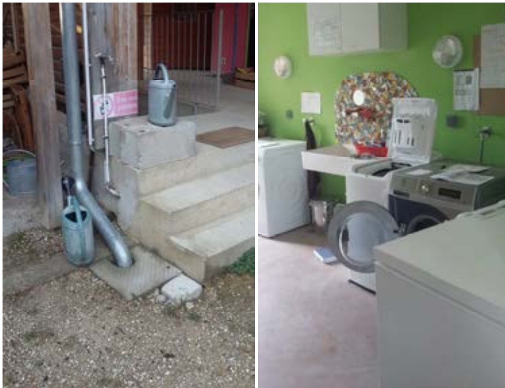
Photo 3 : descente d'eau de pluie en citerne souterraine et extraction par un robinet identifié "non potable"
